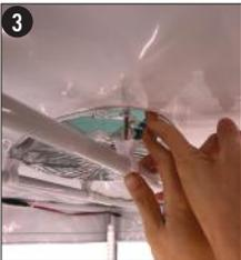
**3** Möglicherweise müssen Sie die Position des Lüfters anpassen, indem Sie ihn entlang der Dachträger schieben, bis er mittig durch den Schornstein ragt.
